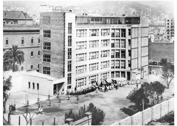
Edifici de l'Institut Nicolás Salmerón, a principis dels anys 30 de segle passat. Després de la Guerra civil, es va anomenar Instituto Público Menéndez y Pelayo.
