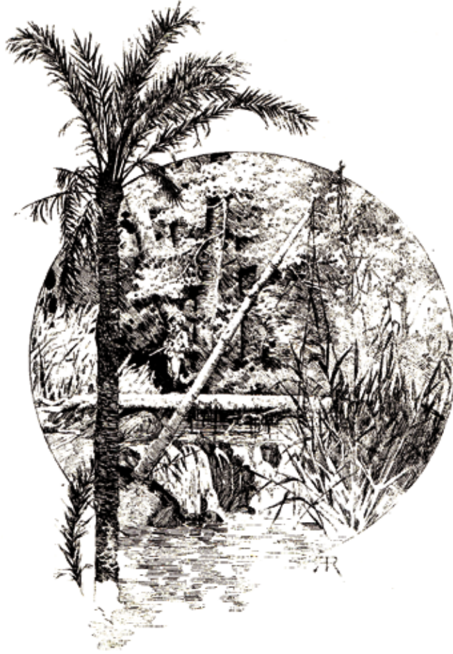
Detàceme en la mitad del puente , formado por el huracan con un cedro corpulento.
